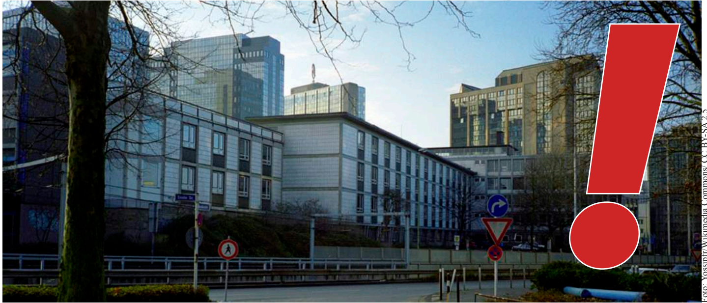
Die Gesamtschulen in Essen sind marode und baufällig, wie hier die Frida-Levy-Gesamtschule im Zentrum von Essen.
